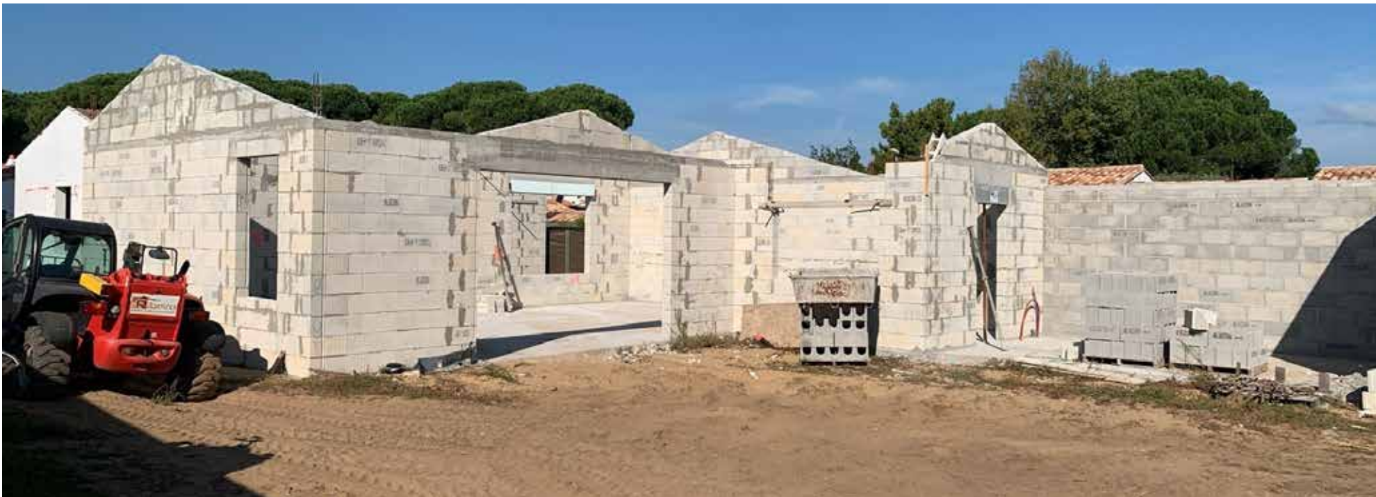
Photo de chantier ; Pov jardin sur façade sud.
