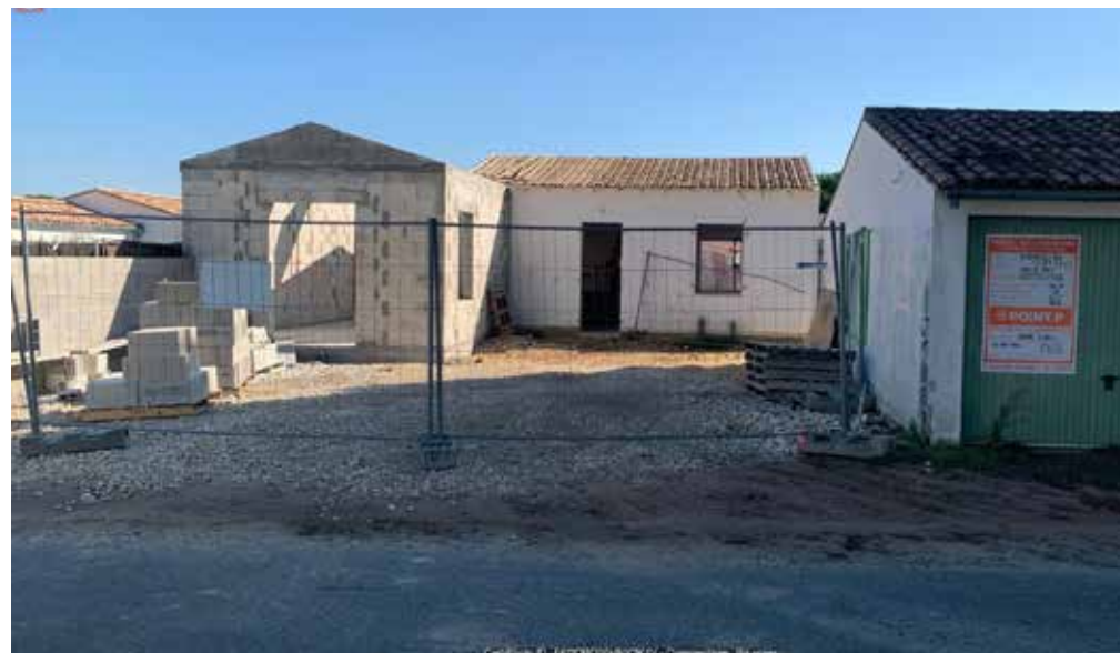
Photo de chantier ; Pov Façade sur rue
