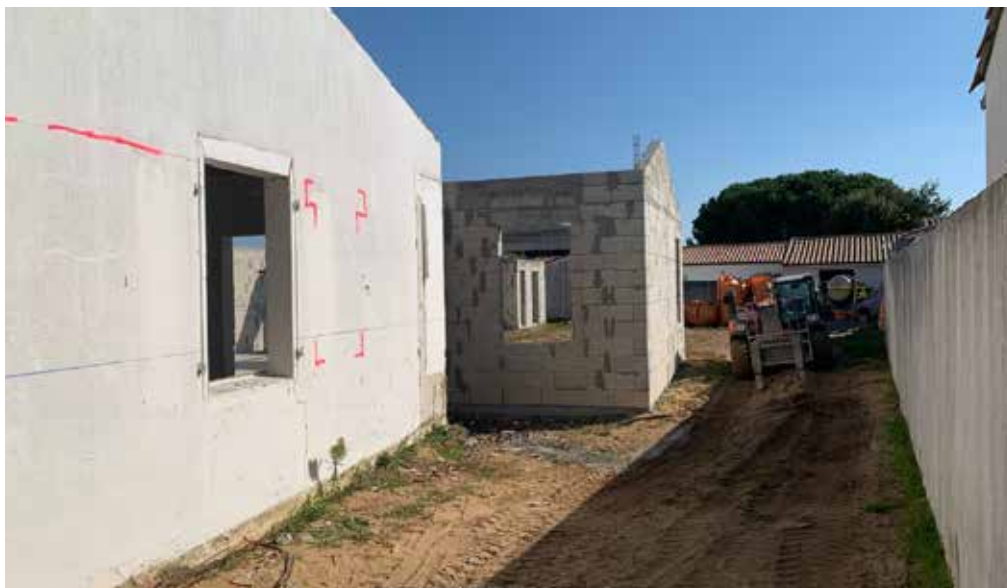
Photo de chantier ; Pov jardin sur façade sud.
